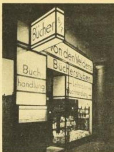
7. Großflächige Kellame-Leuchtscheiben geben für den Buchladen eine gute Werbewirkung ab. Der kleine Ausgangskasten neben dem Eingang ist durch Soffitten erleuchtet. Besonders wirksam ist das quer zur Gehrichtung angebrachte Aussteck-Leuchtschild.
