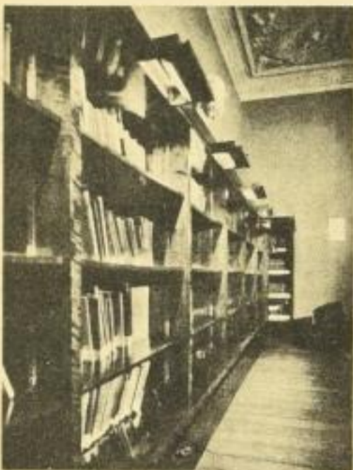
6. Praktische Beleuchtung umfangreicher Wandschränke einer großen Buchhandlung. Über jedem Oberfach sind Soffitten-Lampen in Kästen untergebracht, die sich gut anpassen und deren Lichtausfall durch verstellbare Schieber nach unten hin verändert werden kann.
