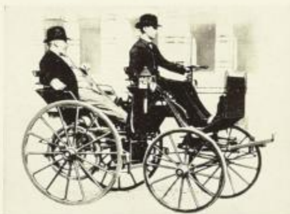
Daimler in seinem ersten, 1886 erbauten Wagen. 11/2 PS, 1 Zylinder, 18 km/Stundengeschwindigkeit. Motor zwischen den Beinen des Fahrgastes.
