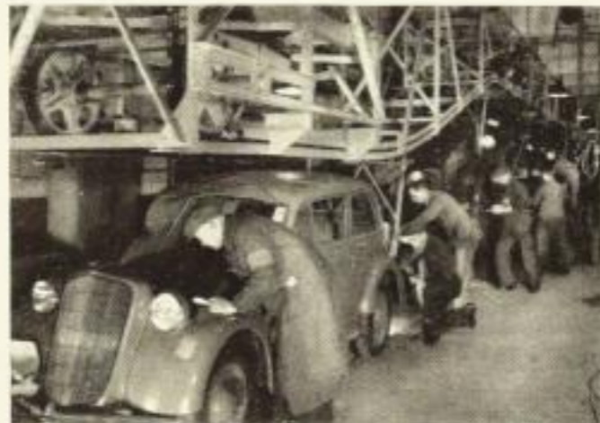
Am Ende des laufenden Bandes. Hinten: Am Montageband hängende Wagen; in der Mitte: absinken auf den Boden; vorn: vom Bande gelöst. Rechts sind Montagewerkzeuge (Kraftwerkzeuge) federnd aufgehängt.
