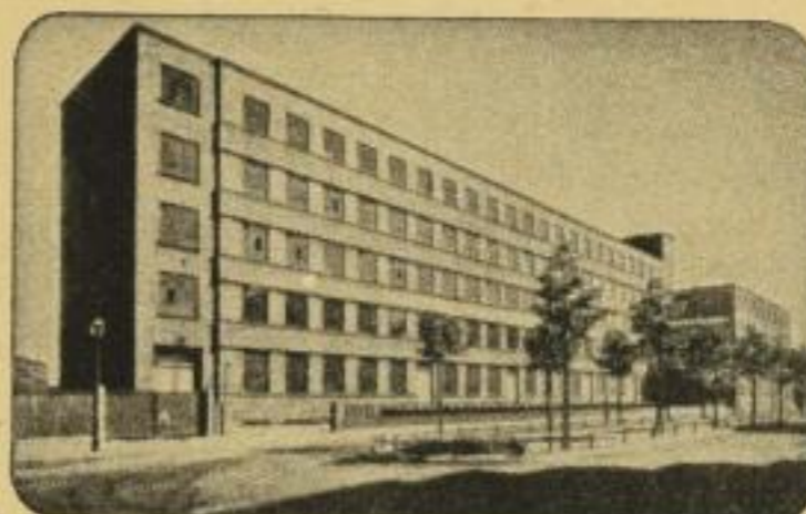
Lagerhaus Dessauer Str. 36-40 Borderransicht
