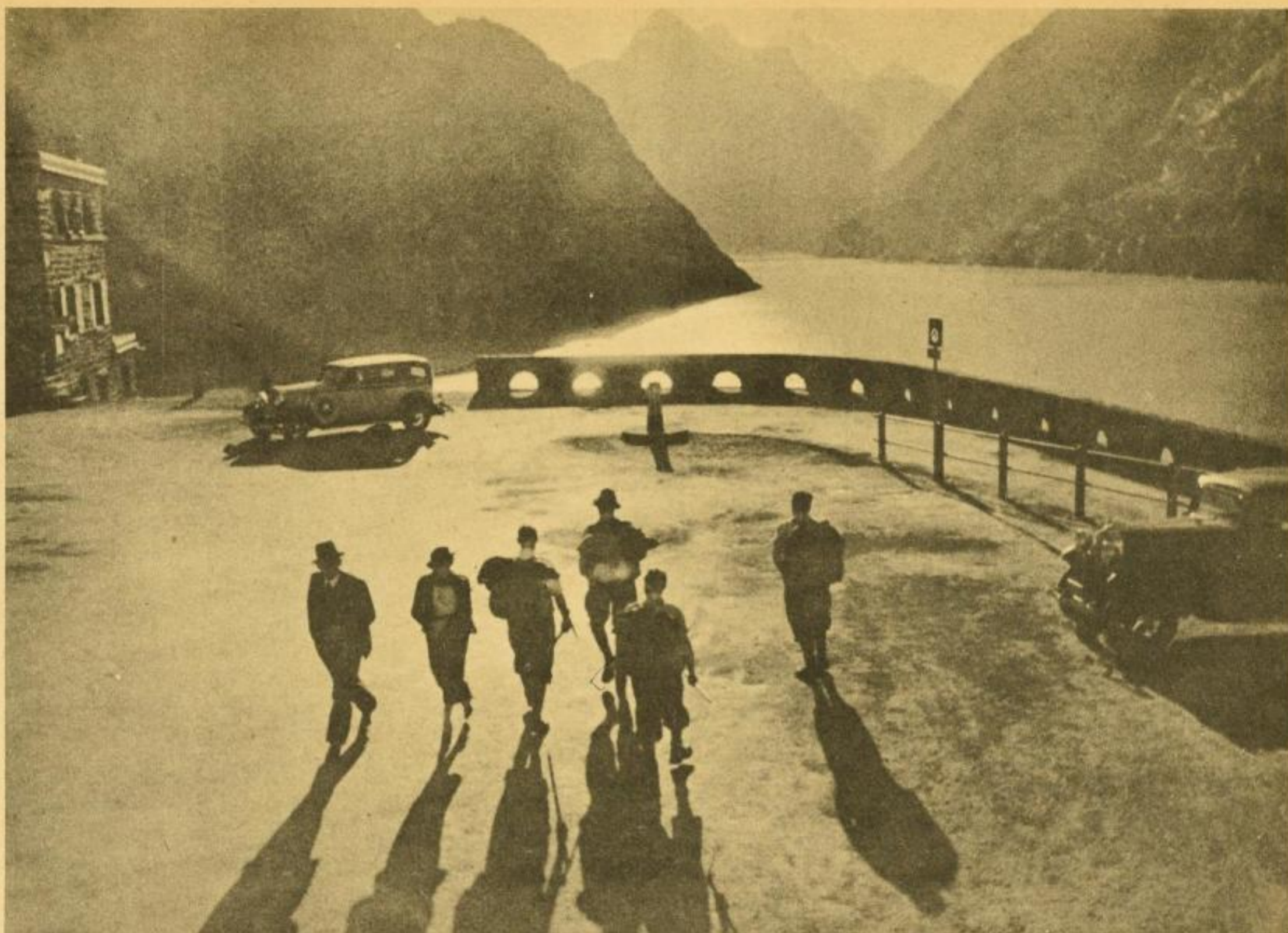
Die Autowendeterrasse am Grimsel-Stausee (2100 m)
