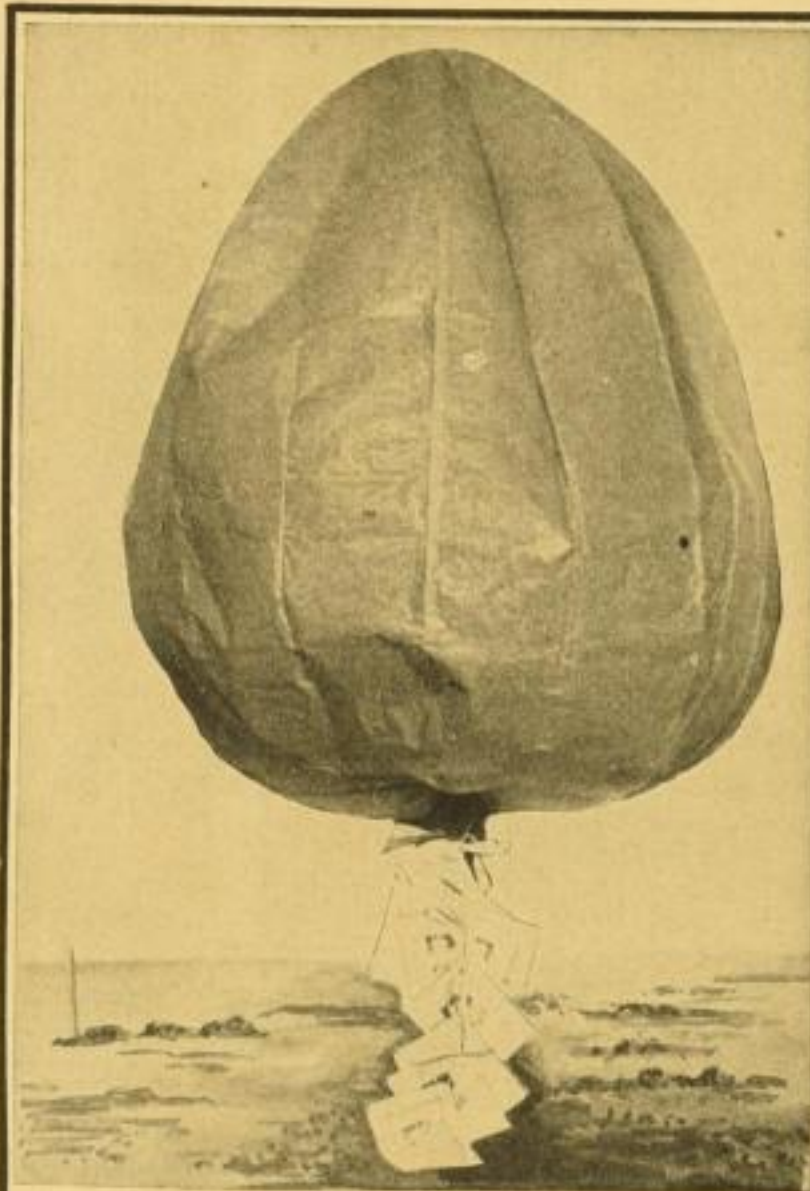
Feindlicher Papierballon mit Flugblättern, die die deutschen Soldaten zum Überlaufen auffordern, in der deutschen Stellung gelandet. Der Ballon war so konstruiert, daß von Zeit zu Zeit ein Flugblattbündel herunterfallen mußte. (Solche vervollkommnete Ballone flogen zuletzt 6000 Kilometer weit!)
