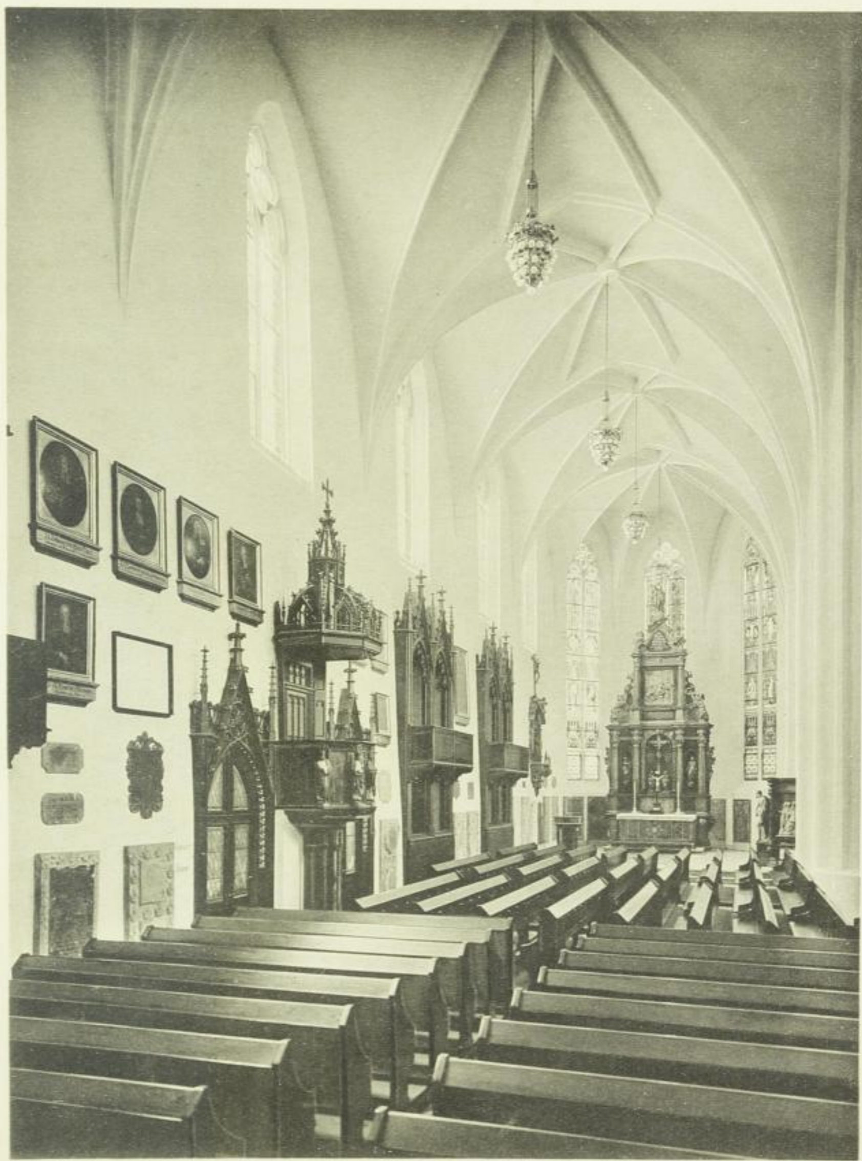
Innenansicht der Kirche nach der Instandsetzung 1910
