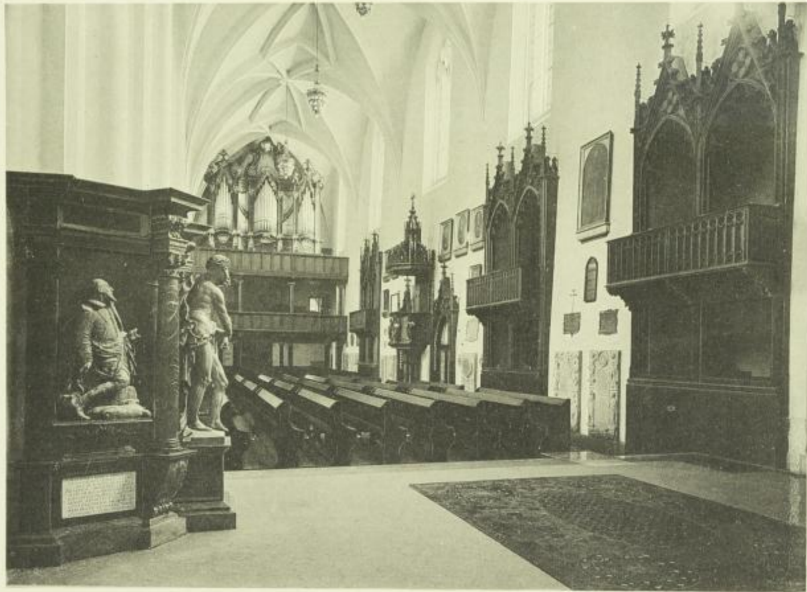
Innenansicht der Kirche nach der Instandsetzung 1910
