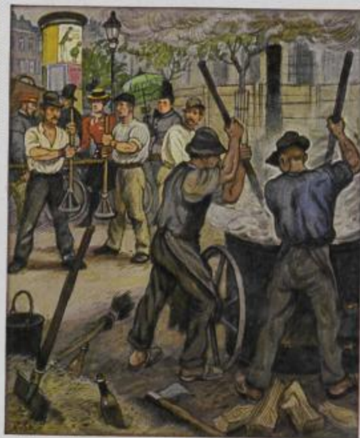
BILD 288: ASPHALTARBEITER. Die alten Germanen stellten die Wege aus Bohlen und Knüppeln her, was dem wald- und moorreichen Lande entsprach. Später genügte zunächst auch noch ein Feldsteinpflaster. Der wachsende Verkehr verlangte bessere Verkehrswege. Das neue Reich baut große Autostraßen, die das Land wie ein Netz durchziehen, um den Ansprüchen eines raschen, dichten Verkehrs zu genügen.
