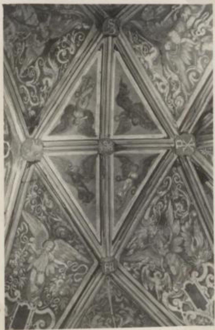
Decke im Altarraum. Phot. Liebert
