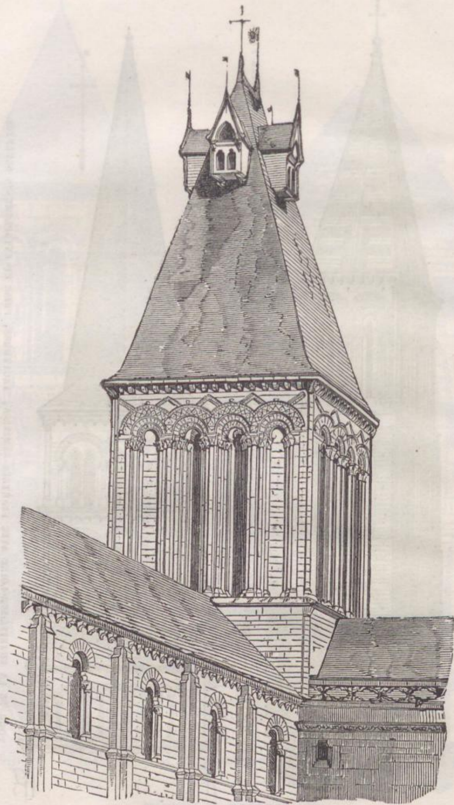
TOUR ROMANE AU CENTRE D'UN TRANSEPT, SURMONTÉE D'UN TOIT EN CHARPENTE DU XVI e . SIÈCLE AVEC QUATRE LANTERNES AU SOMMET.
