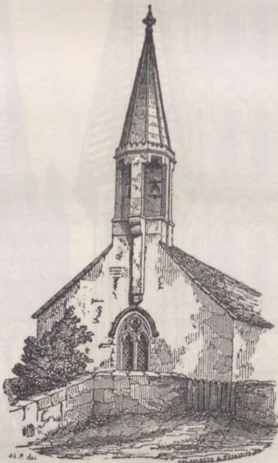
TOUR DE L'ÉGLISE DE CORSTON (ANGLETERRE).
