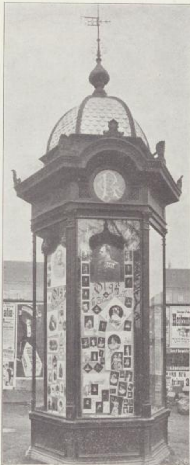
Kiosk des Atelier Olga-Wien; Aufnahme von Ch. Scolik-Wien.
