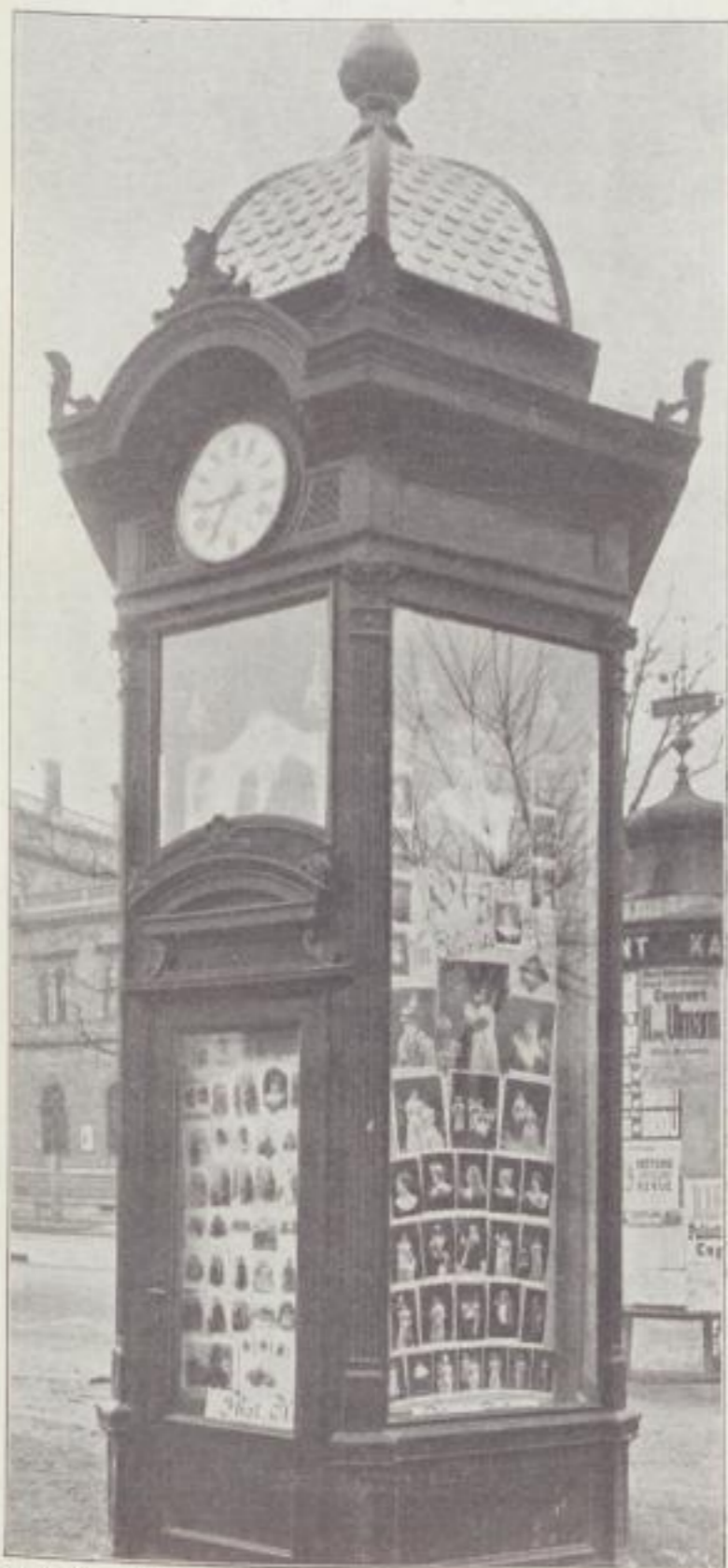
Kiosk des Atelier Olga-Wien; Aufnahme von Ch. Scolik-Wien.
