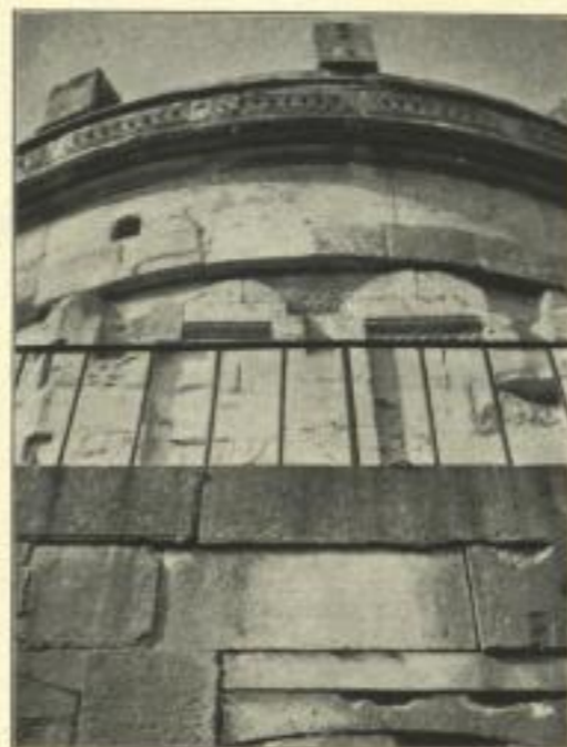
No. 12. Deckschicht des Unterbaus.
