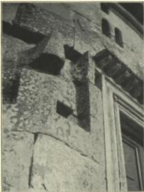
Abb. 16. Vertiefungen neben der oberen Türe.
