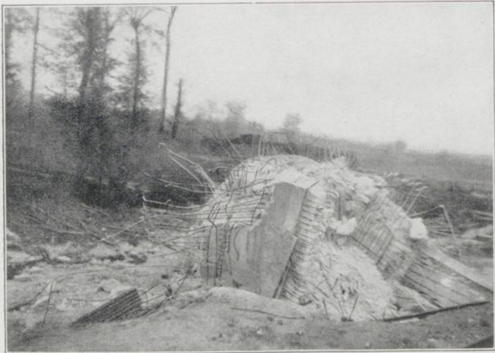
23. Durch Granate ausgehobener Betonblock in Flandern.
