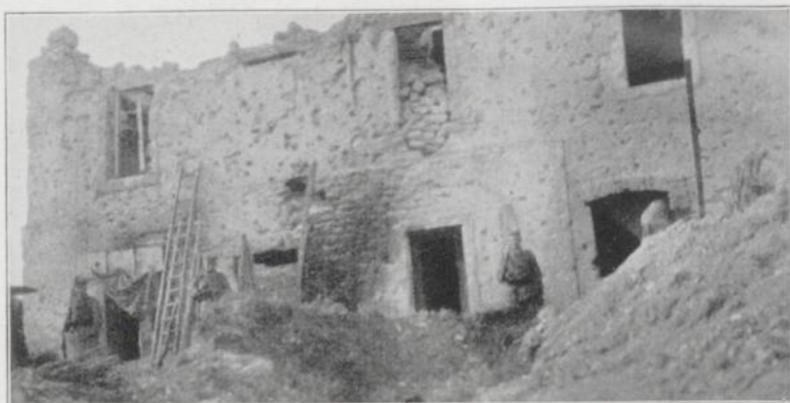
8. Rückseite des Schleusenhauses.
