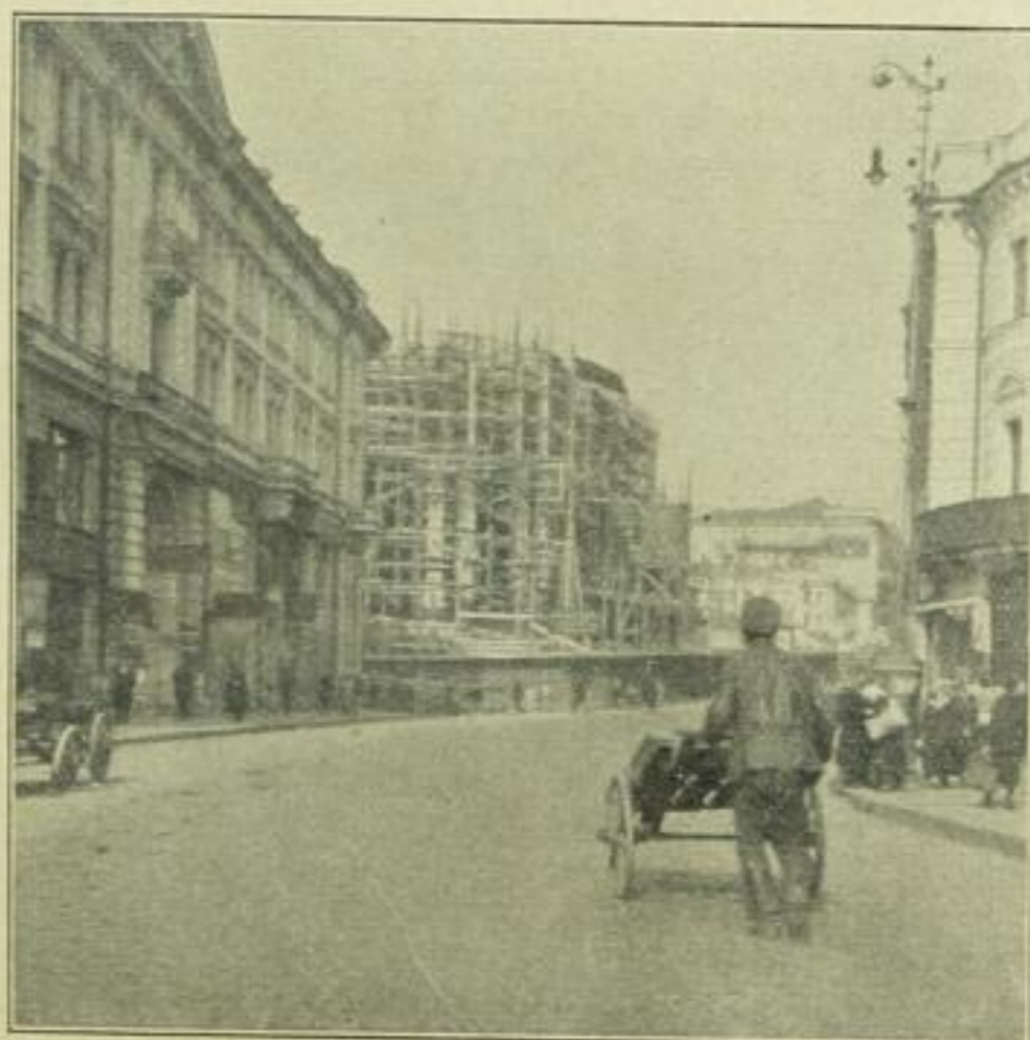
Neubau des Telegraphenamtes in Moskau
