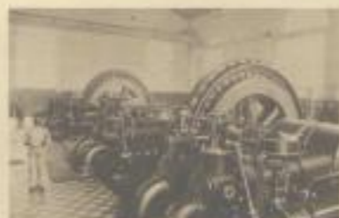
Zwei Deutzer Doppeltaktender, Modell G.D.Z., von je 500 PS, im Elektrizitätswerk der Stadt Bala-Hortostre (Dänemark).
