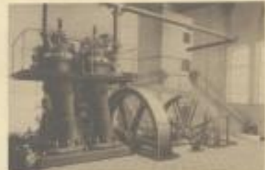
Deutzer Dieselmotor von 160 PS in einer Mühle.
