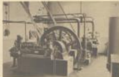
Deutzer liegender Dieselmotor von 20 PS in einer Brauerei.
