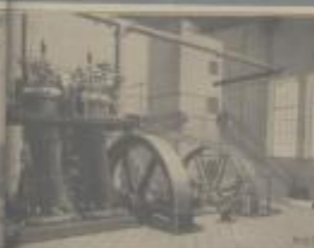
1400 PS Deutscher Dieselmotor der 1100er-Linie in stehender Bauart in einer Fabrik
