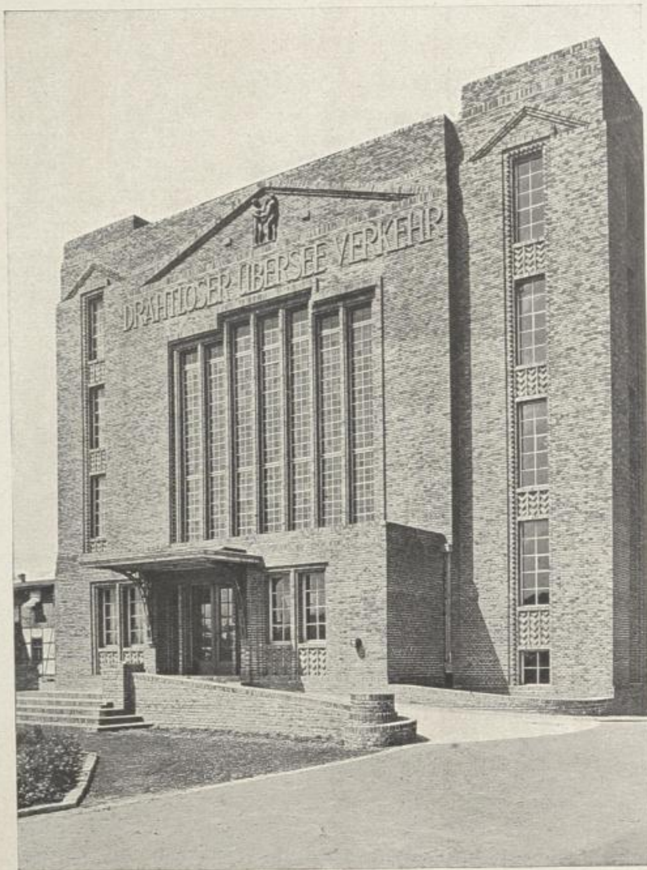
Bild 9 / HERMANN MUTHESIUS / Mittelbau der Großfunkenstation Nauen.
