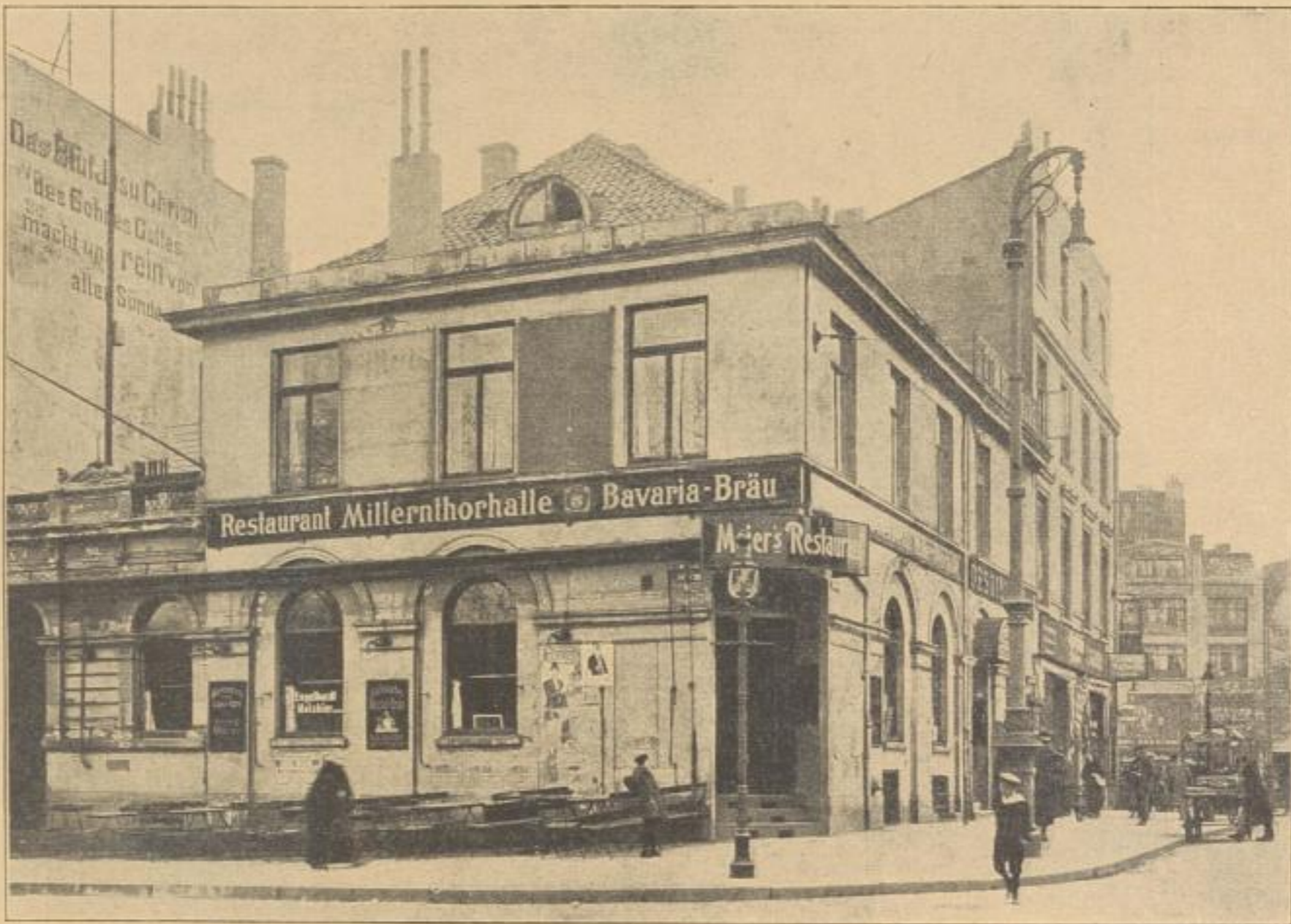
Bild 10 / Schlechte Außenreflamme, Hamburg, Zeughausmarkt
