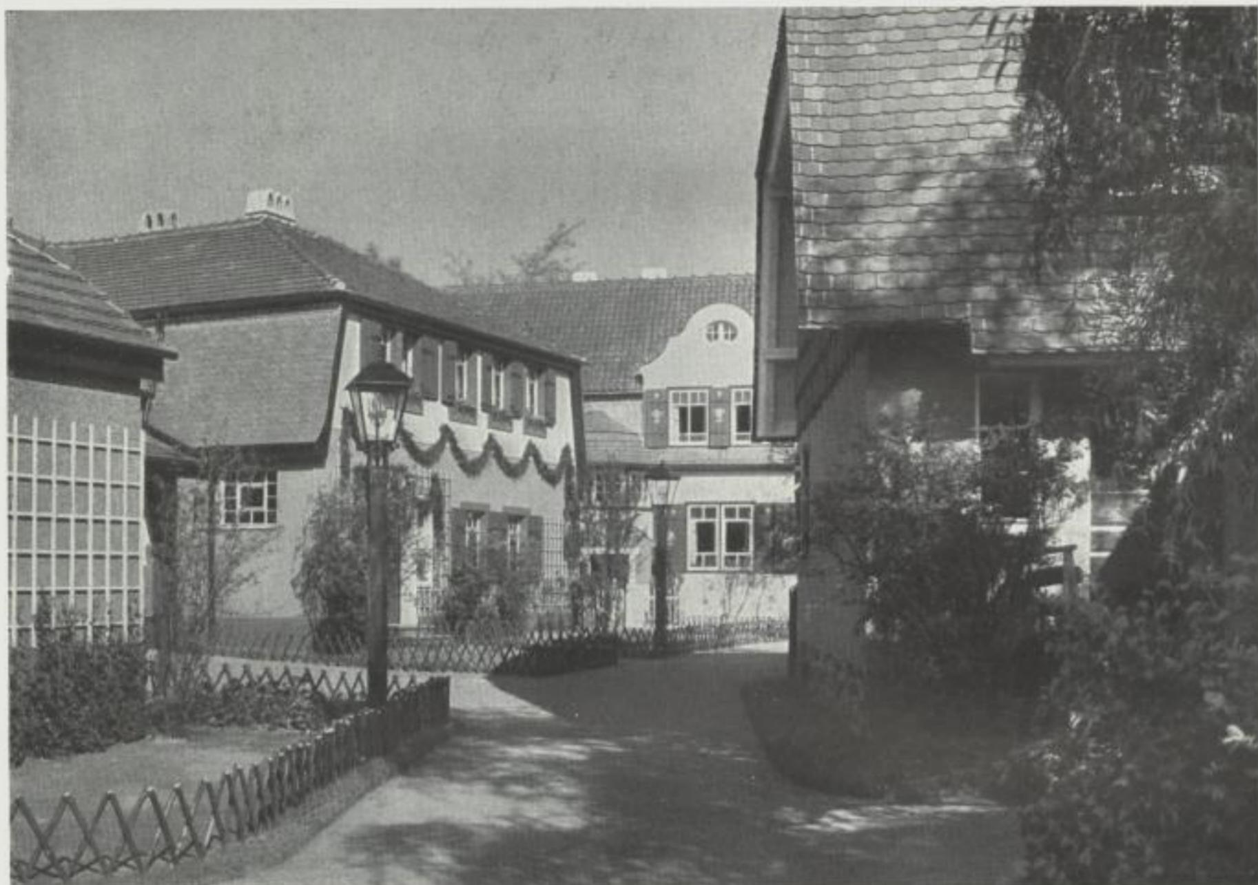
DER DORFPLATZ MIT BLICK AUF DAS VON ARCH. AUGUST GROTHE-DRESDEN GEBAUTE VIERFAMILIEN-WOHNHAUS
