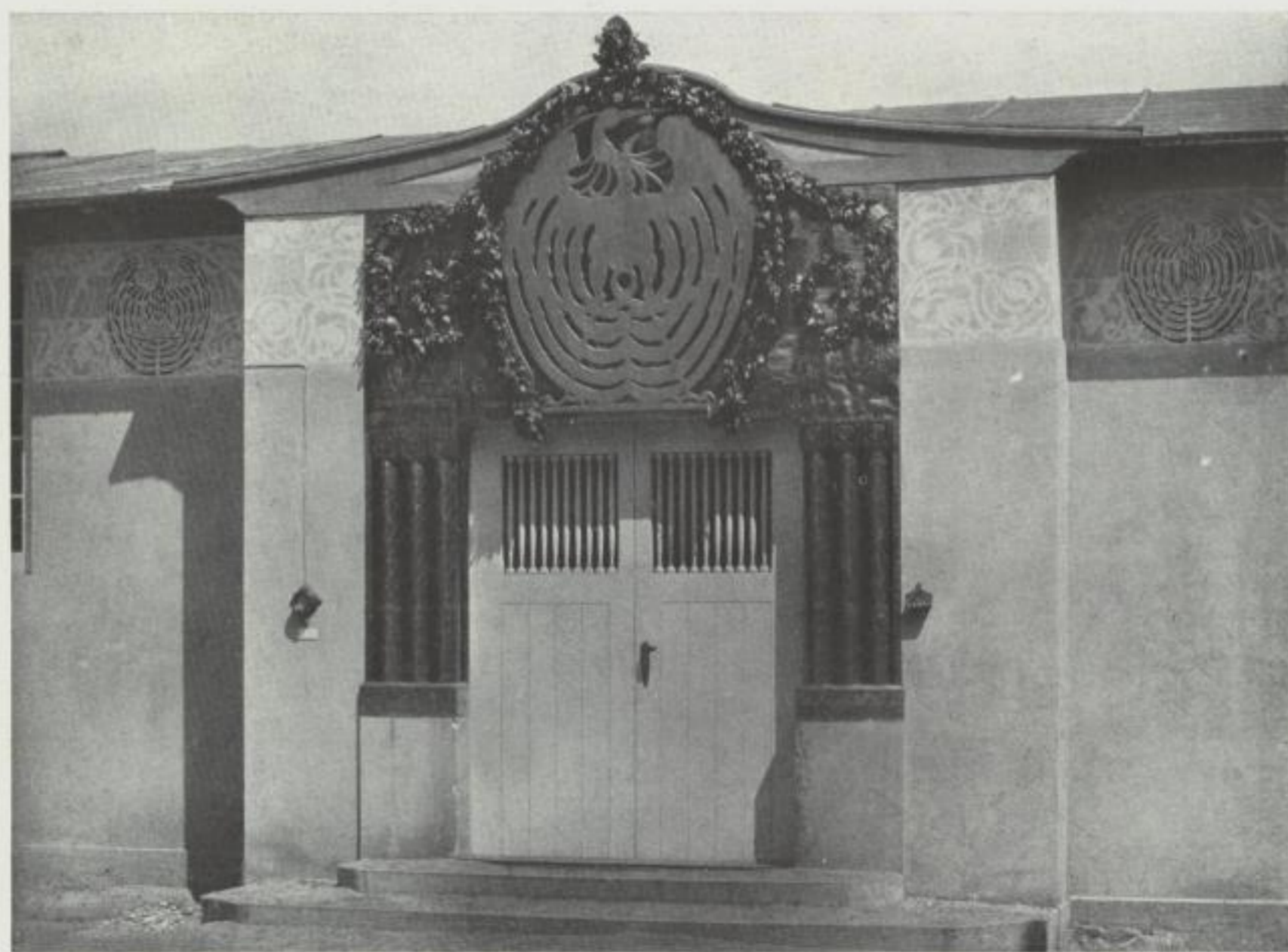
RICHARD RIEMERSCHMID-PASING b. MUNCHEN EINGANG ZUR AUSSTELLUNGSHALLE AUSFÜHRUNG: DRESDENER WERKSTÄTTEN FÜR HANDWERKSKUNST, DRESDEN
