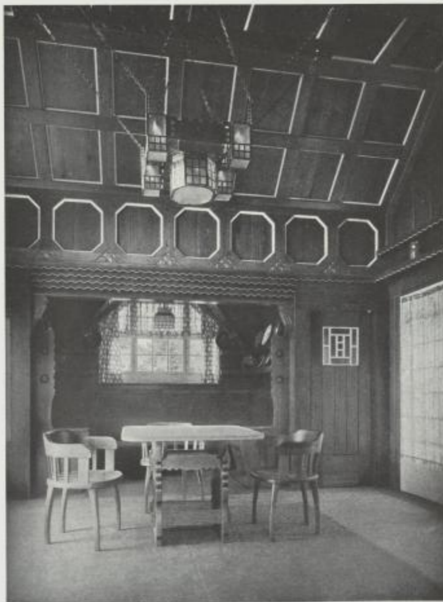
WILLIAM LOSSOW-DRESDEN • INNENANSICHT DES PARKHÄUSCHENS (VGL. S. 60) AUSFÜHRUNG DER HOLZARBEITEN: ERNST NOACK, DRESDEN
