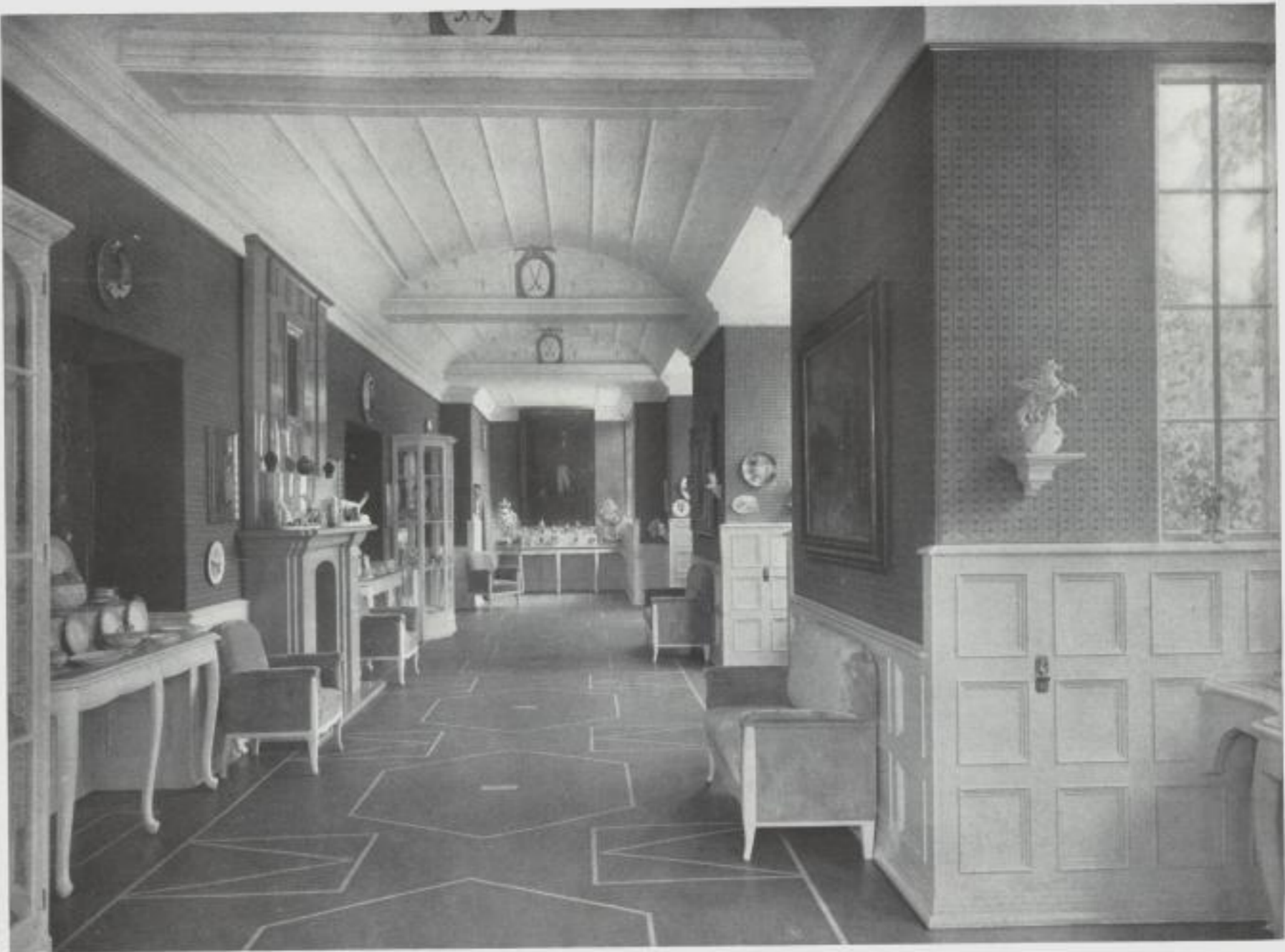
WILHELM KREIS-DRESDEN AUSSTELLUNGSRAUM DER KGL. SÄCHSISCHEN PORZELLANMANUFAKTUR MEISSEN AUSFÜHRUNG DES DECKENGEWÖLBS: PETER HENSELER, DRESDEN; DER WANDESPPANNUNG: JOH. TEICHMANN, DRESDEN; DES FUSZBODENS: TORGAMENTWERKE, G. M. B. H., LEIPZIG
