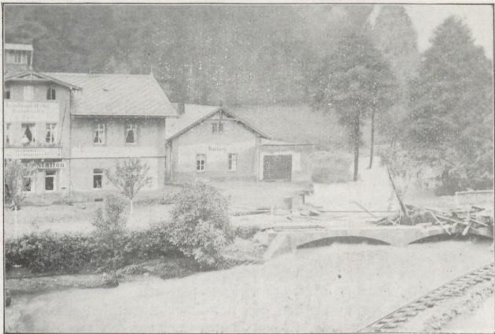
Straßenbrücke beim Hotel zur Post in Glashütte
