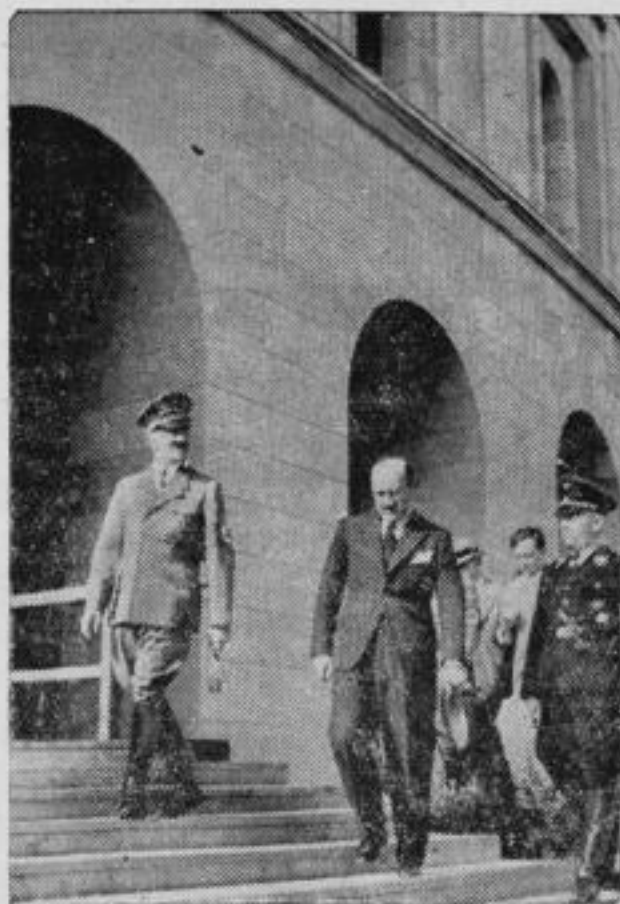
Der Führer besichtigte die Arbeiten auf dem Reichsparteitaggelände
