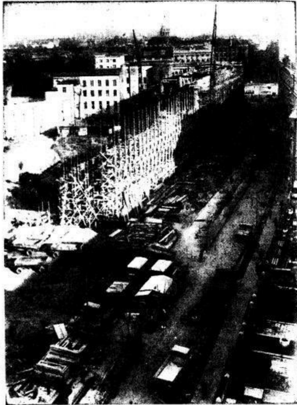
Zur Neugestaltung der Reichshauptstadt: Die Erweiterungsbauarbeiten der Reichskanzlei in der Voßstraße in Berlin. Im Hintergrund, über dem Baugerüst (im Bild links) erkennt man die Rückseite der Reichskanzlei. Aufnahme: Presse-Bild-Zentrale
