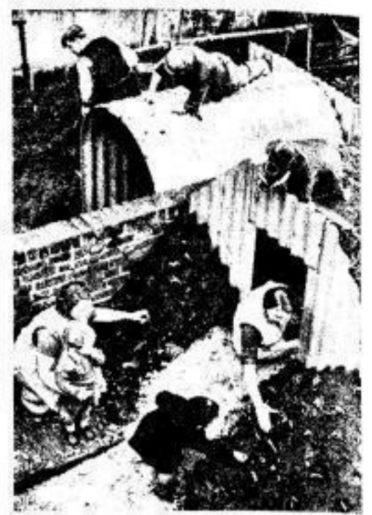
In England werden neuartige Luftschutzkeller „fertig ins Haus“ geliefert. Es handelt sich um dickes Stahlblech, das nur zusammengeschraubt zu werden braucht und im Ernstfall mit Sandsäcken geschützt wird.
