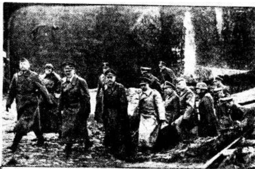
Der Führer und (rechts) Reichsminister für Bewaffnung und Munition Dr. Todt bei der Besichtigung von Befestigungsbauten Presse-Hoffmann, Zander (K.)
