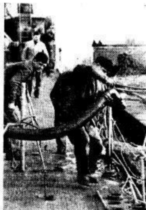
Deutsches Kriegsschiff nimmt Treibstoff über. Die Brennstoffübernahme kann in kurzer Zeit erfolgen. Es ist nur nötig, daß ein Schlauch mit einem Anschlußstutzen auf den Brennstofftank aufgesetzt wird, und das Öl kann übergepumpt werden. P. K. Borch, Presse-Hoffmann
