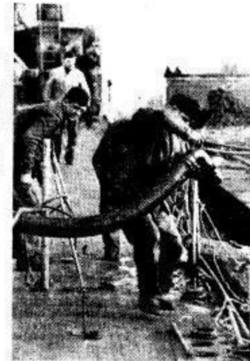
Deutsches Kriegsschiff nimmt Treibstoff über. Die Brennstoffübernahme kann in kurzer Zeit erfolgen. Es ist nur nötig, daß ein Schlauch mit einem Anschlußstutzen auf den Brennstoftank aufgesetzt wird, und das Öl kann über gepumpt werden. PK-Borch, Presse-Hoffmann
