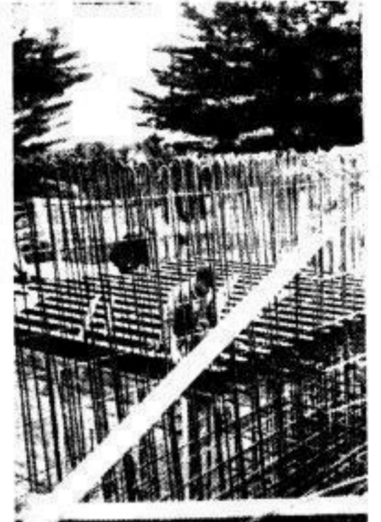
Die Abwehrfront an der Atlantikküste. Eisenstäbe werden kreuzweise miteinander verbunden und ergeben die „Kubische Armierung“, die den Bunkerraum umschließt.
