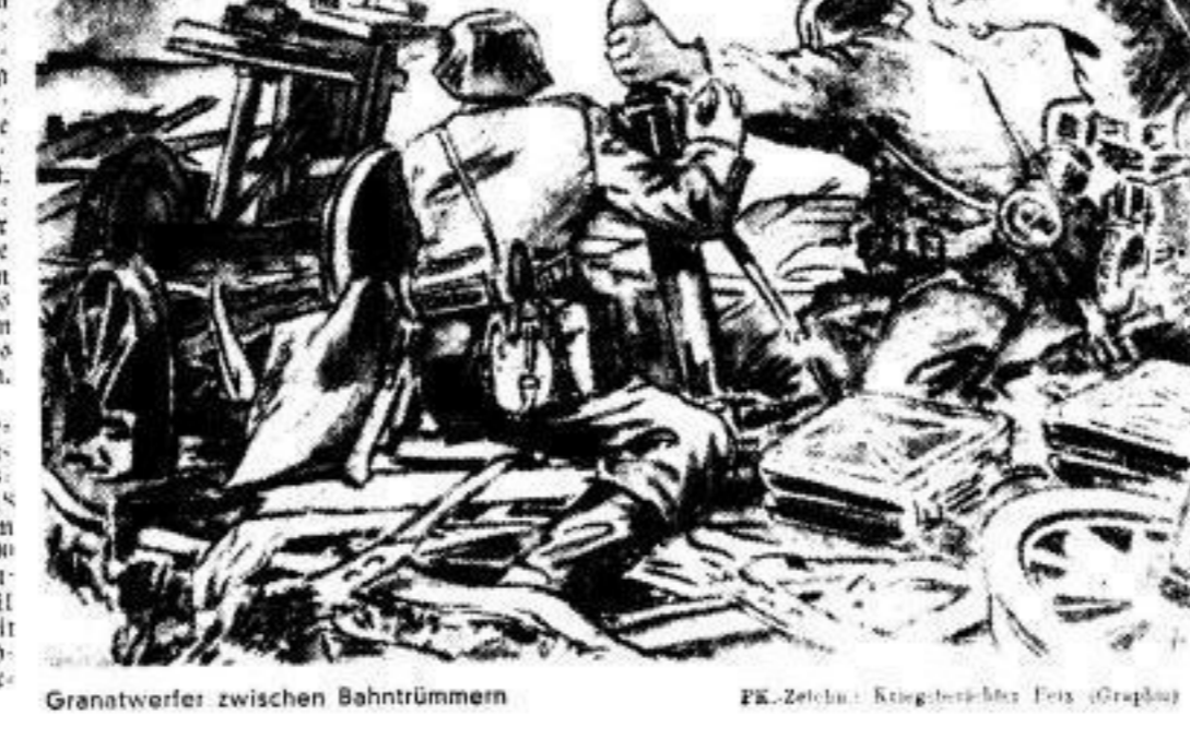
Granatwerfer zwischen Bahnrümmern
