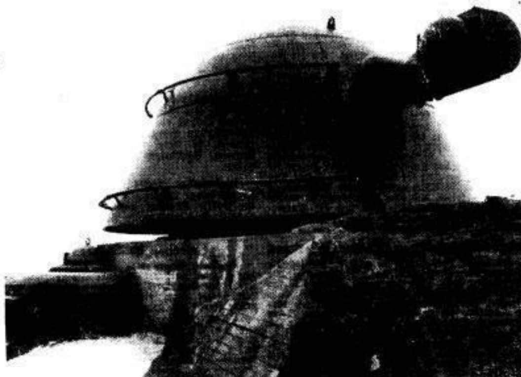
Schwere Panzertürme sichern die Küste
