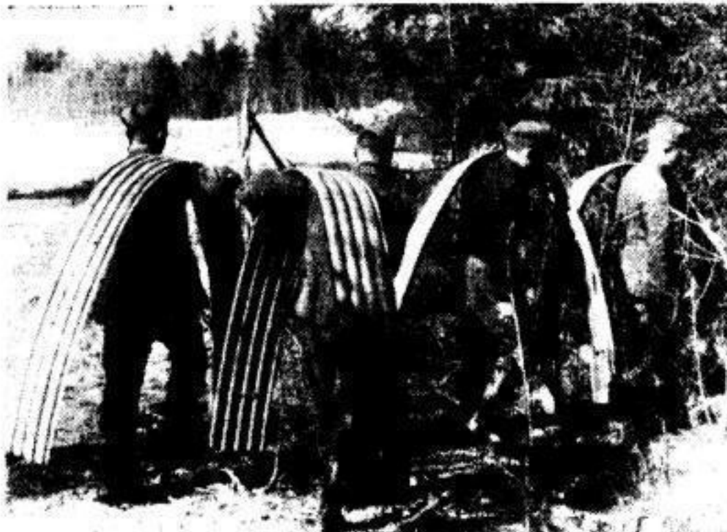
„Siegfriedrahmen“ werden herangeschleppt: Im Waldgelände der mittleren Ostfront verwenden unsere Grenadiere mit Vorliebe diese Wellblechrahmen zum Abdecken von Schützenlöchern. Mehrere davon aneinandergesetzt und mit Erde beworfen geben ein wasserdichtes Dach und bieten einen guten Splitterschutz. PK-Autor: Krieger, Witke (A. 1.)
