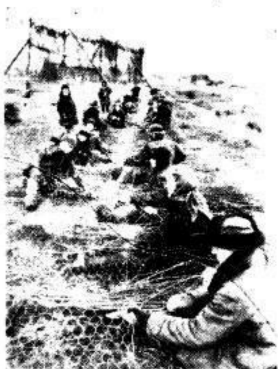
Aus Drahtgeflecht und Reisig entsteht hier unter den geschickten Händen der Zivilbevölkerung eine lange Tarnblende, die den Sowjets die Einsicht in eine unserer Nachschubstraßen nehmen soll
