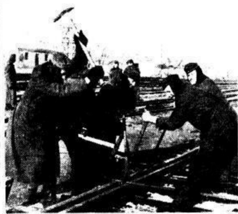
Eisenbahnpioniere nageln Gleise auf deutsche Spur um PK. Kriegerdorf, Schmalbork (Pba.)
