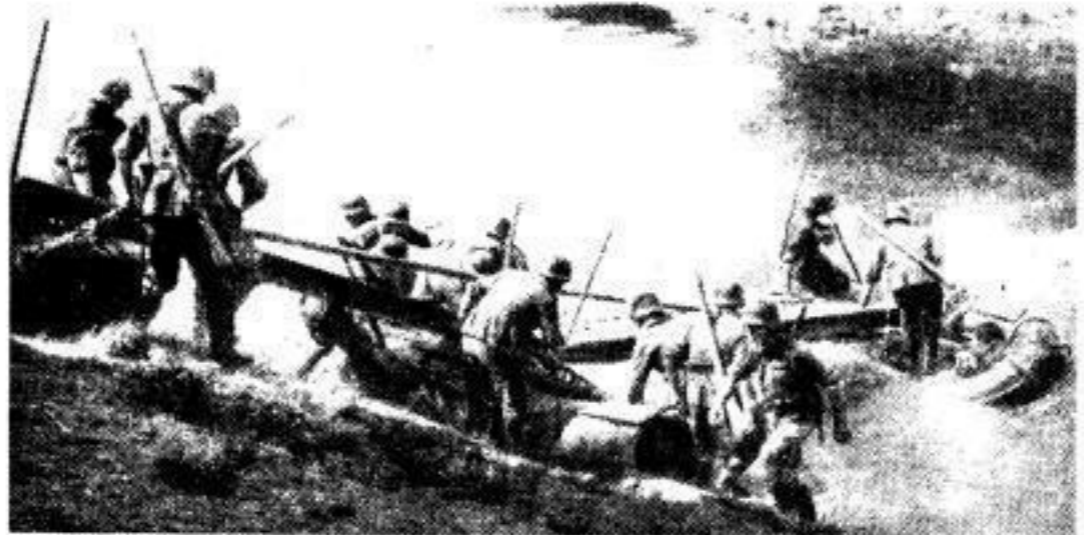
Floßsocktag, der über einen schmalen Fluß in zwei bis drei Minuten gelegt wird.
