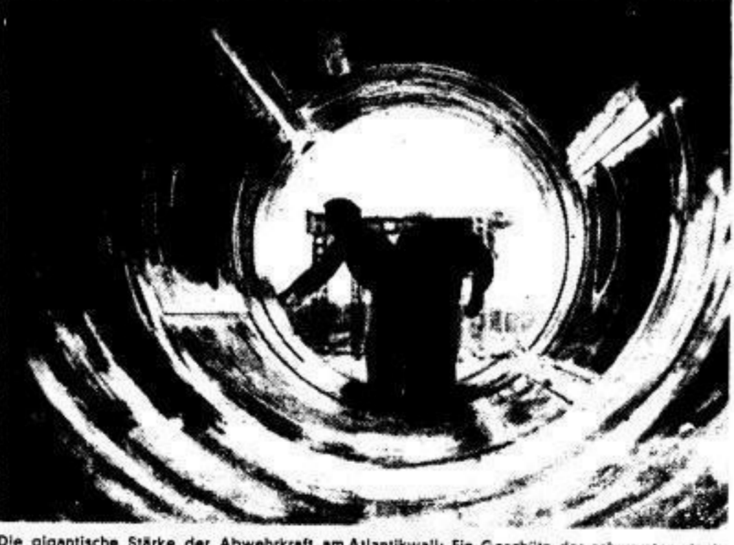
Die gigantische Stärke der Abwehrkraft am Atlantikwall: Ein Geschütz der schwersten deutschen Artillerie wird aufgebaut. In der Verschlußkammer des Rohres kann man bequem stehen.
