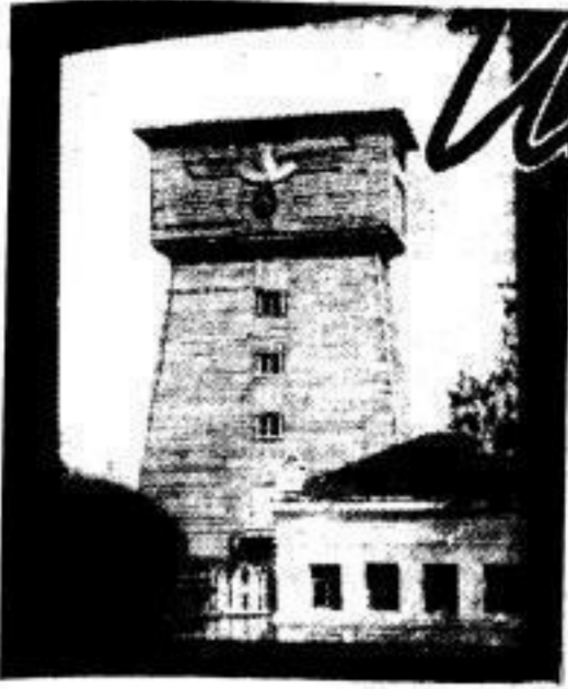
Auf einer ukrainischen Bahnstation errichtete der Baustab Speer diesen Wasserturm zur Versorgung der Lokomotiven
