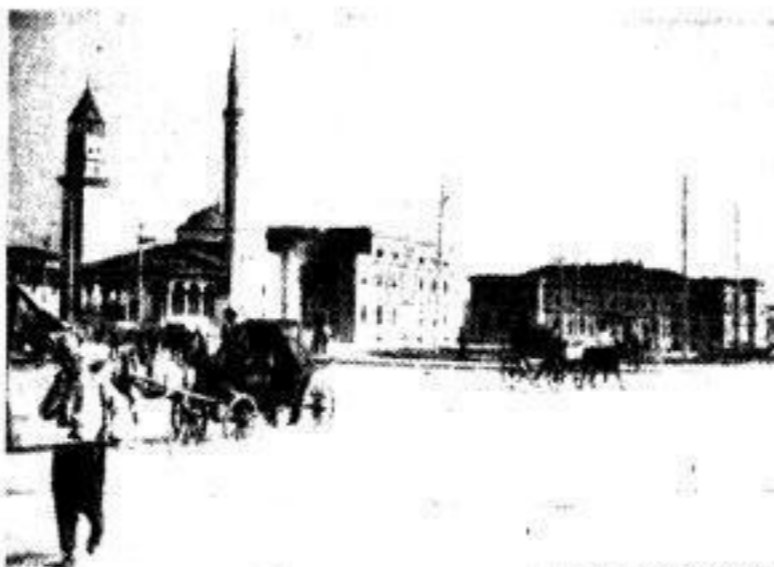
Ein paar Pferdewagen rollen über den Hauptplatz, den Tiranas Regierungsgebäude umgeben. Links vorn: die alte Moschee.
