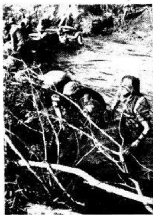
Pioniere sorgen für einen Uebergang. An einer seichten Stelle sollen hier Panzer einen Fluß durchqueren. Die Pioniere, die den geeigneten Platz ausgesucht haben, sind soeben damit beschäftigt, den Uebergang mit behelfsmäßigem Material zu unterbauen.
