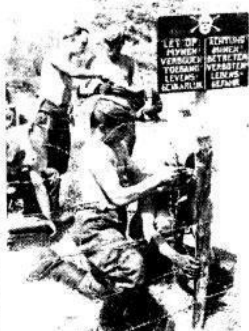
Pioniere verminen das Dünengelände an der Kanalküste
