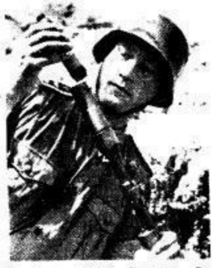
Karabiner schießt Granaten. Der Schießbecher ist augesetzt, die Granate wird eingeführt. Der Karabiner wird statt mit einer Patrone mit einer Kartusche geladen...
