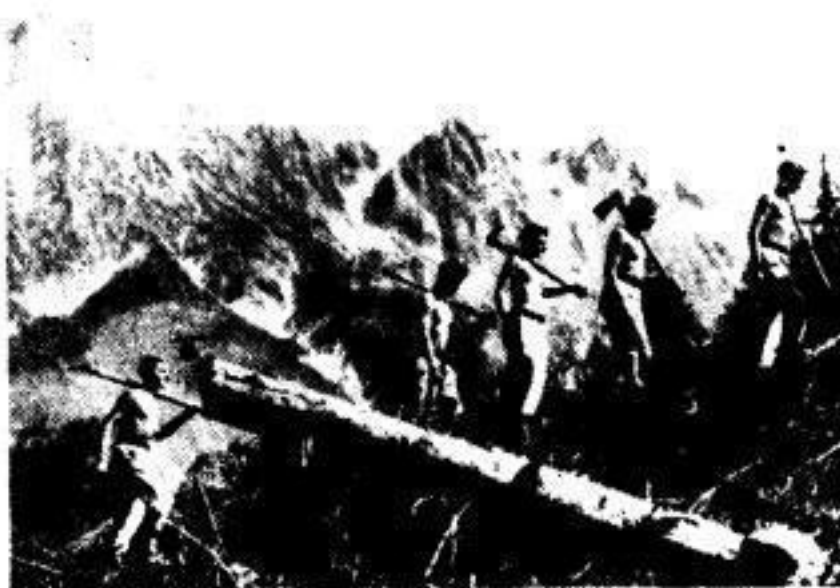
Der Aufstieg zur Arbeitsstelle. Arbeitsmänner im Hochgebirge wücken zu ihrer Baustelle aus. Aufnahme: RAD-Kriegsberichterstatter Tomsek (W.).
