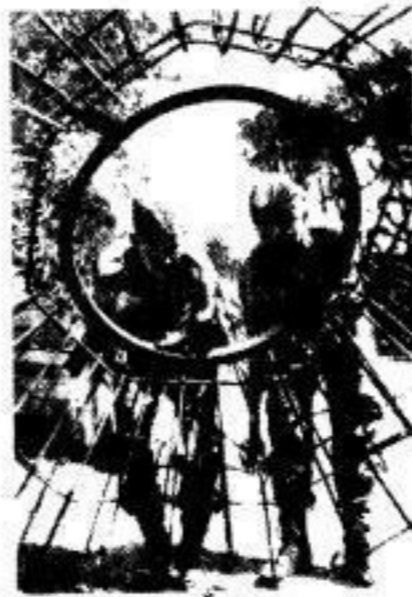
Kriegseinsatz des RAD am Mittelmeer. Wieder ist eine Eisenarmierung fertiggestellt, die in einem Bunker eingesetzt wird. RAD-PK.-Aufn.: Kriegsberichtler Arnold (PBE)
