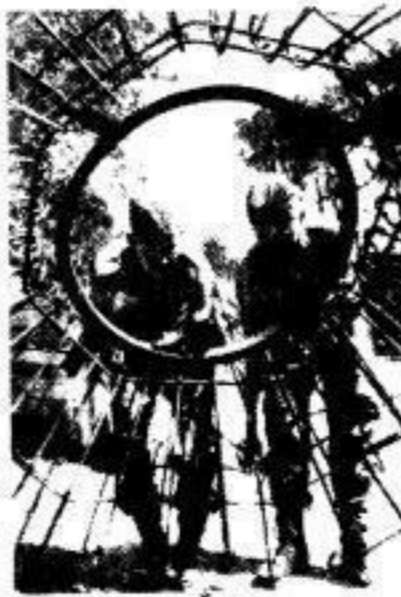
Kriegseinsatz des RAD am Mittelmeer. Wieder ist eine Eisenarmierung fertiggestellt, die in einem Bunker eingesetzt wird. RAD-PK.-Aufn.: Kriegsberichtler Arnold (PBE)
