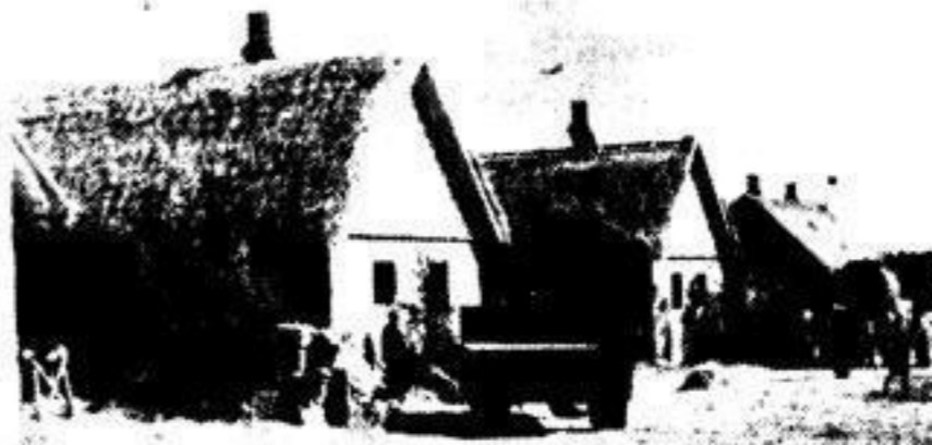
Um im bevorstehenden Winter den Flugzeugbesatzungen eine gute Unterkunft sicherzustellen, werden Siedlungen angelegt, die in ihrer Bauart der in der betreffenden Gegend ortstüblichen angeglichen sind. — Hier eine Lehmhauseinsiedlung irgendwo im Osten, die soeben fertiggestellt wurde. PK-Aufnahme; Kriegsberichtler Jötte (Sch.).
