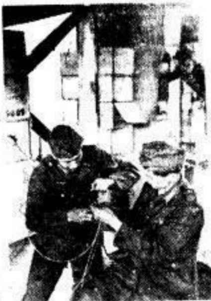
Leitungen zur Sprengung einer Brücke werden geschaltet
