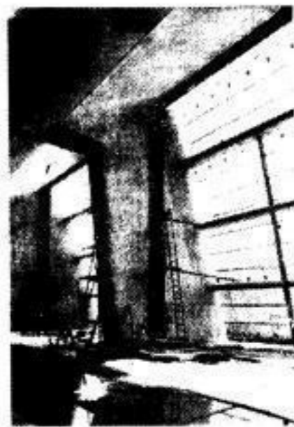
Bauten für die Energieversorgung: Die gewaltigen Stahl- und Betonkonstruktionen, die das Einlaufwerk für ein modernes Fließkraftwerk größten Ausmaßes bilden.
