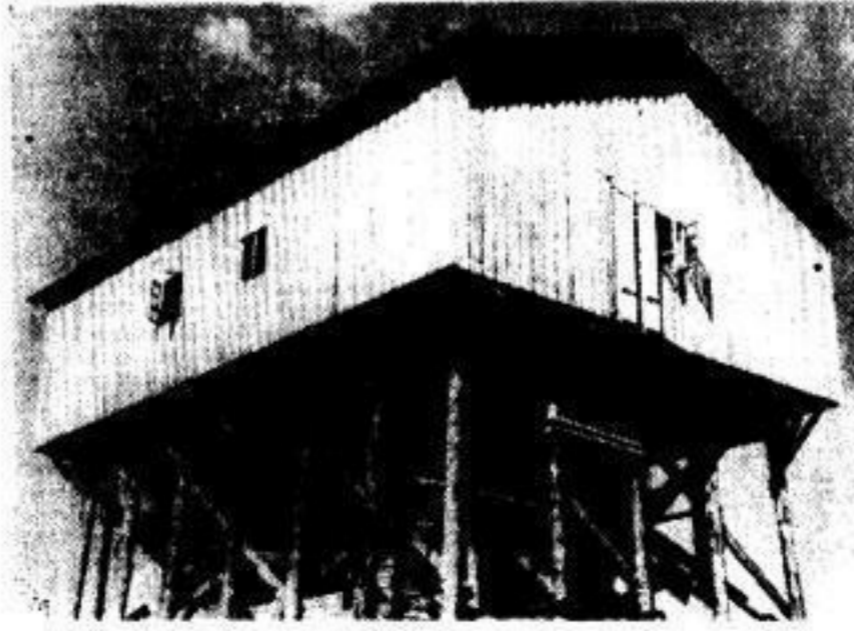
Baustellen der OT. Dieser Wasserturm versorgt die Lokomotiven mit Wasser. In drei Wochen wurde er unter den widrigsten Verhältnissen von der OT. gebaut.
