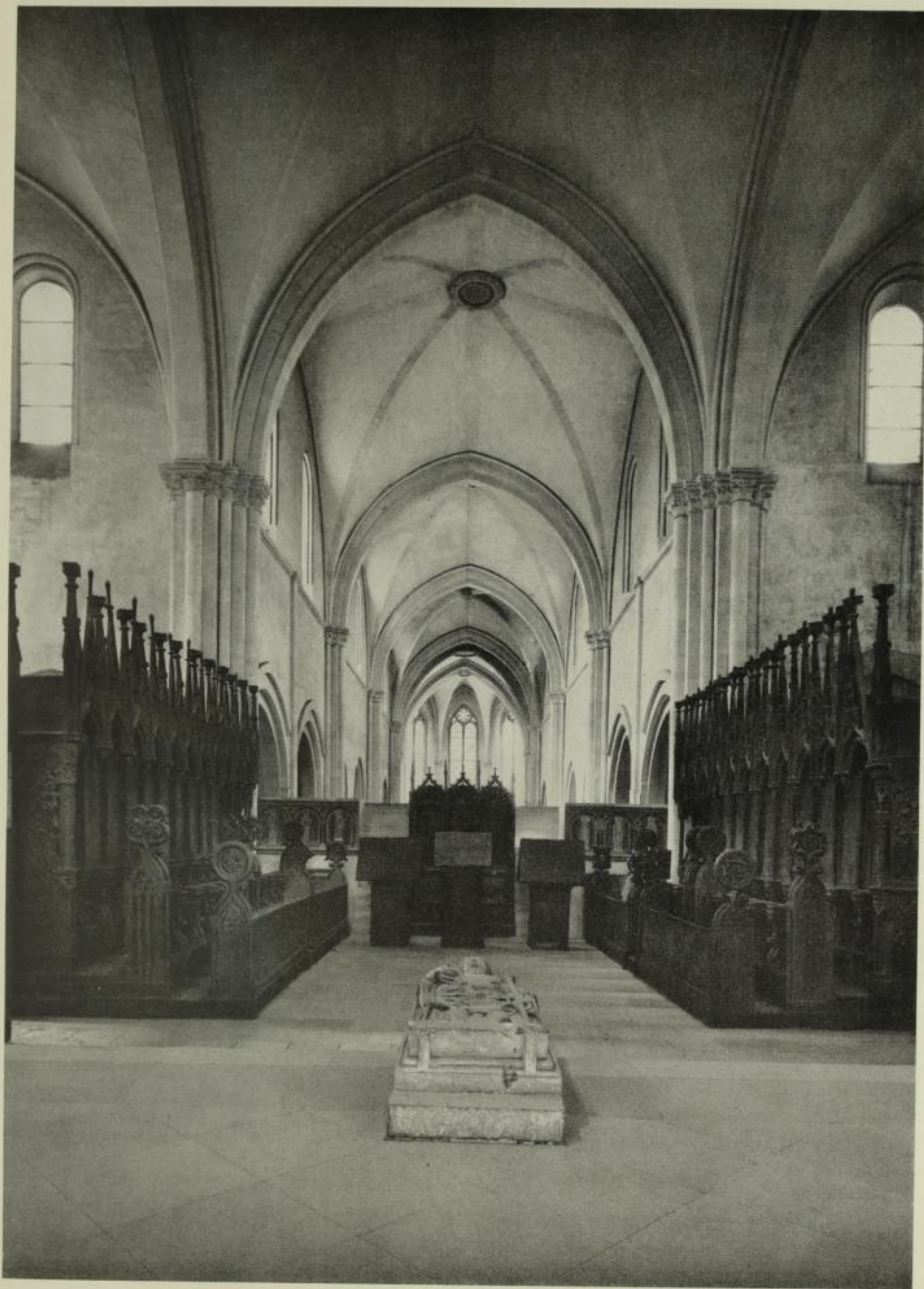
Blick vom Ostchor in die Gewölbe des Mittelschiffes
