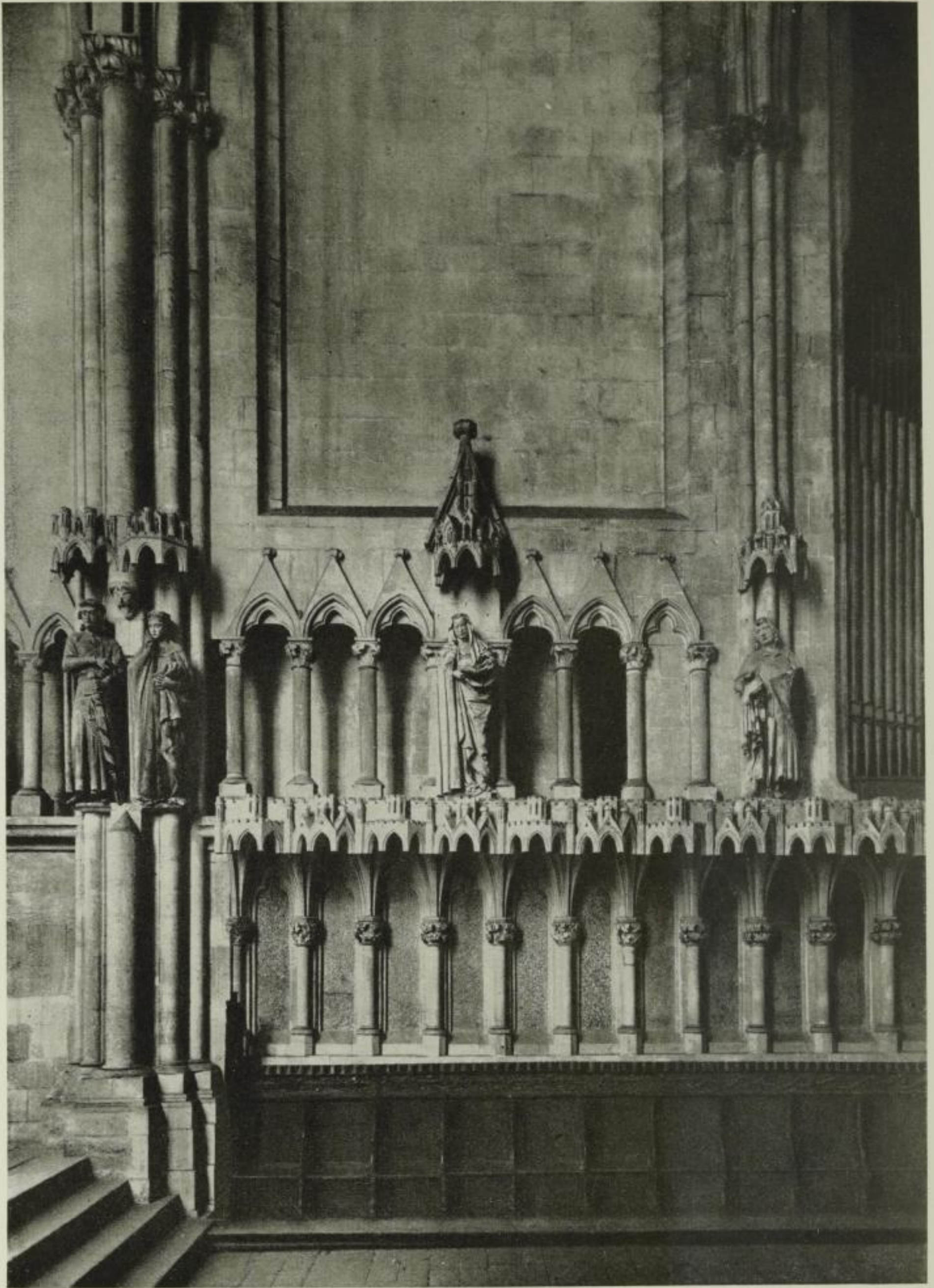
Nordwand des Chorquadrums
