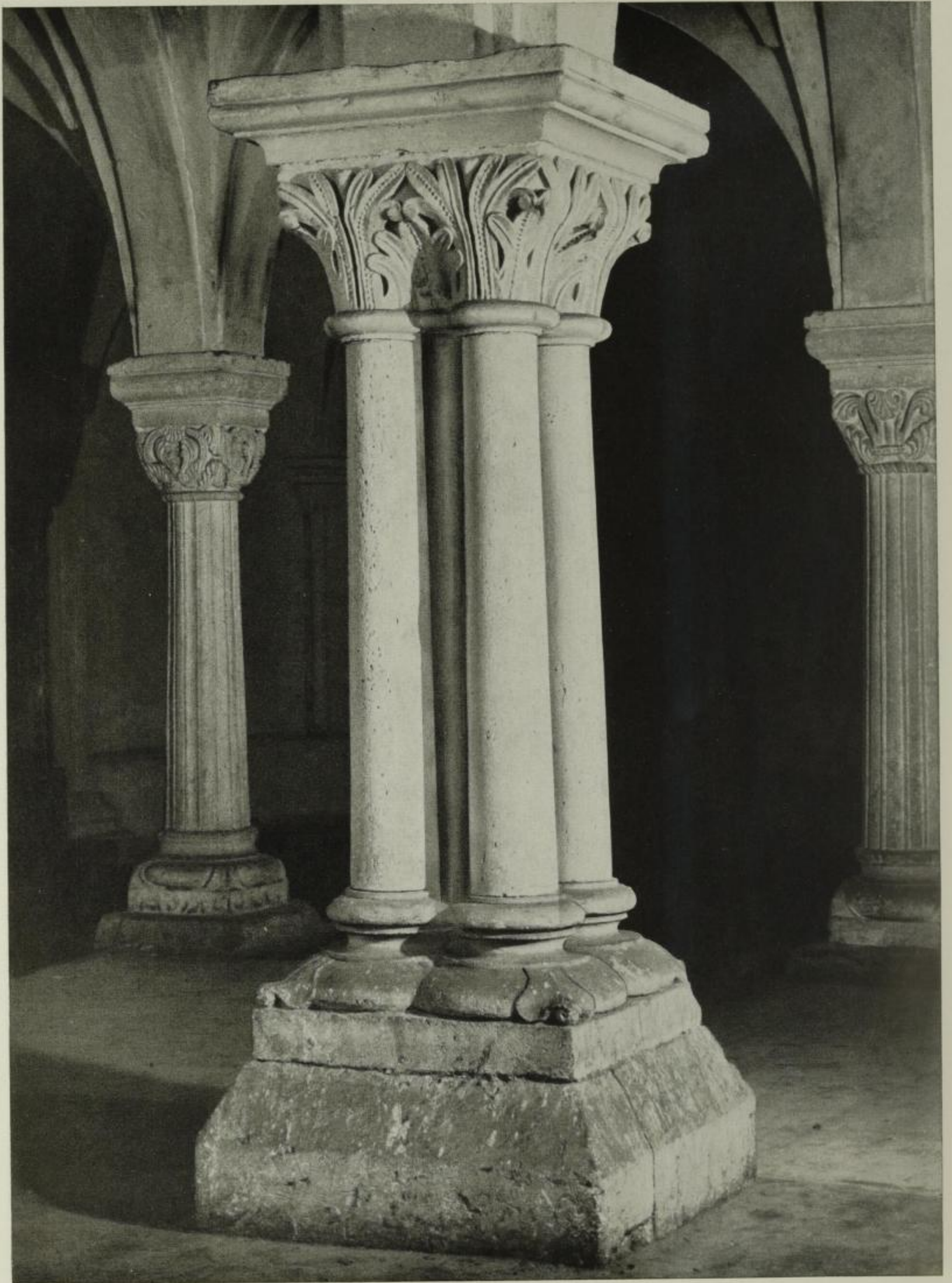
10 KRYPTA, BÜNDELPFEILER DES APSIDENRAUMES
