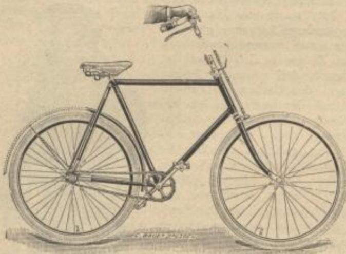
Besonders zweckmässig erscheint die von der Firma Seidel & Naumann-Dresden auf den Rädern dieser Firma bzw. an den Marken «Germania» 6, 9 u. 10 eingeführte und patentierte **abnehmbare Lenkstange**.
